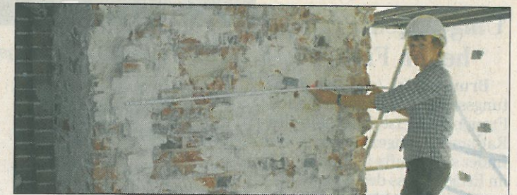
Architektin Christine Scheer zeigt, wie weit die Gewindestangen in das Mauerwerk reichen.
